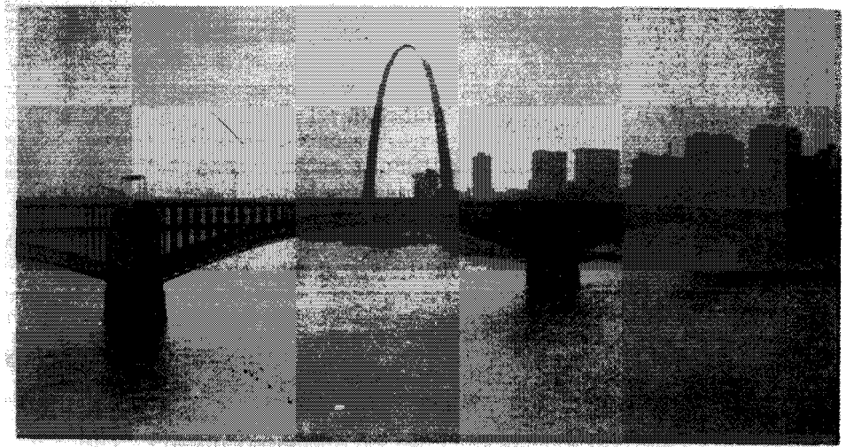
Figura 1-1 El puente Eads a través del Mississippi en St. Louis, Missouri. Este puente de ferrocarril y carretera, terminado en 1874, representa uno de los primeros usos del acero de alta resistencia ( F_y = 50 a 55 kip/pulg 2 ) en los Estados Unidos, para una estructura importante. Al fondo se puede ver el arco de Sto Louís, con 192 m ( 630 pies) de altura, cubierto con una película de acero inoxidable.
