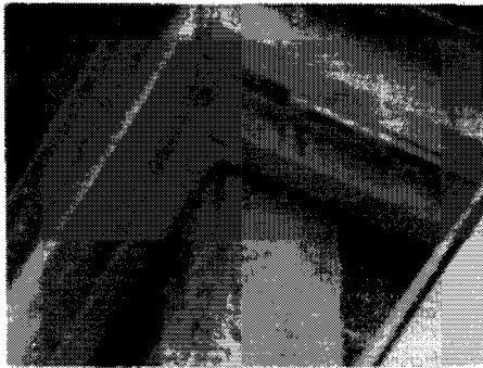
Figura 1-5 Métodos para obtener la resistencia a los incendios de los miembros estructurales de acero. a) Fibras rociadas. b) Listones y yeso. c) Concreto ligero (colado). d) Tableros de yeso - se usan los tableros para aumentar el espesor. e) Detalle del material aislante, rociado en una esquina. El espesor aumenta mediante varias rociadas. f) Detalle del material aislante rociado sobre la viga.
