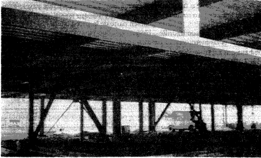
Figura 1-18 Estructuración del piso. Las travesas son las secciones de mayor peralte a las que se conectan las vigas de piso. Se usa un tablero metálico sobre las vigas y donde se colará el concreto para producir un piso compuesto. Los miembros diagonales que se muestran constituyen el contraventeo de la armadura. La dirección de las vigas de piso con respecto a las travesas determina la dirección del flujo de carga, desde cualquier piso hasta la cimentación.
