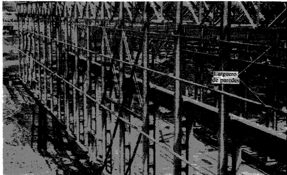
Figura 1-17 Largueros de la pared exterior conectados a las columnas usando segmentos cortos de angular atornillados con pernos de alta resistencia. Refiérase a la figura 4-1b para largueros parcialmente instalados en un edificio industrial usando columnas acarteladas y secciones de cabios. Nótese los largueros que descansan sobre los cabios.
