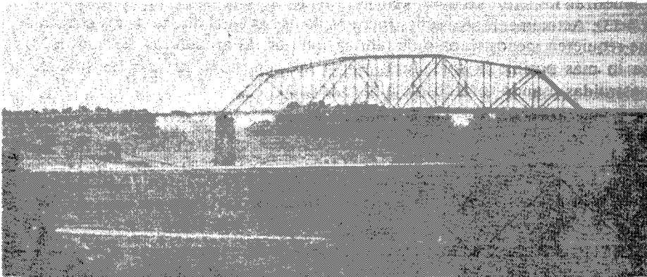
Figura 1-19 Uso de una armadura del tipo de tablero superior para el claro de aproche y de una armadura de tablero inferior para la luz principal. Nótese el contraventeo lateral aproximadamente a la mitad de la altura de la armadura principal para reducir la longitud no soportada de los miembros verticales de la armadura. La geometría particular de las diagonales se usa para reducir la longitud sin apoyo de los miembros diagonales.
