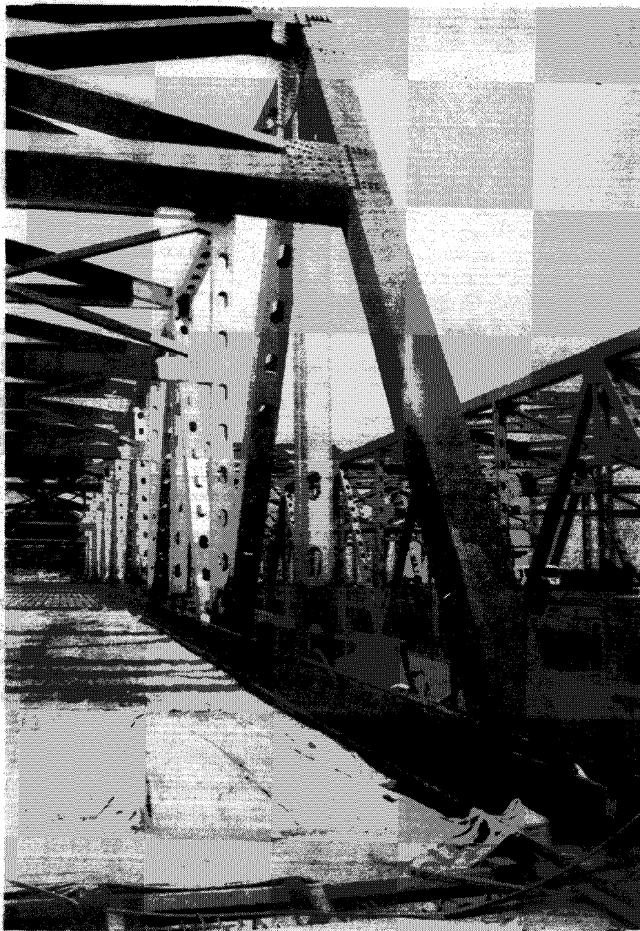
Figura VI-1 Miembro a compresión, poste termmal de un puente. El poste termmal es armado y la construcción es toda soldada. Las juntas se fabrican en el campo, utilizando tornillos de alta resistencia.
