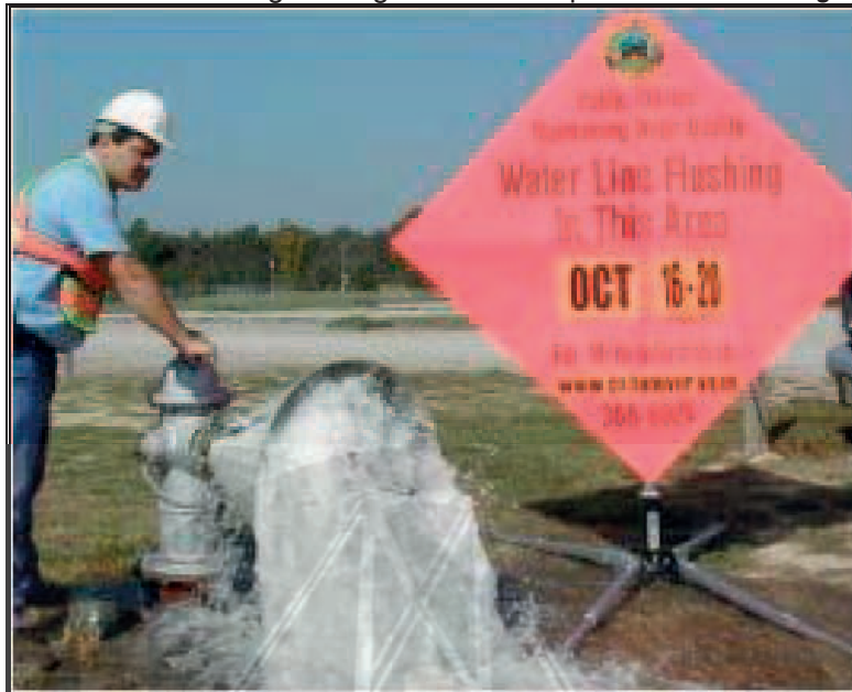
FIGURA 4-1: Descarga del agua durante el proceso de “flushing”
