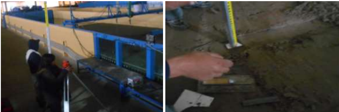
Figura 4. Nivelación de losa de fondo (IMT, 2020)
