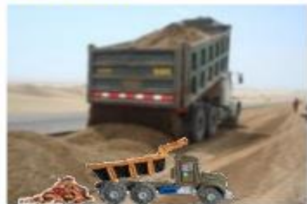
IMAGEN DEL MATERIAL DE BASE GRANULAR COLOCÁNDOSE EN PLATAFORMA
