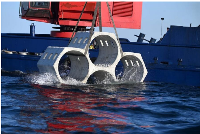
Figura 10. Módulo SEAHIVE de concreto impreso en 3D instalado en aguas de Florida.
