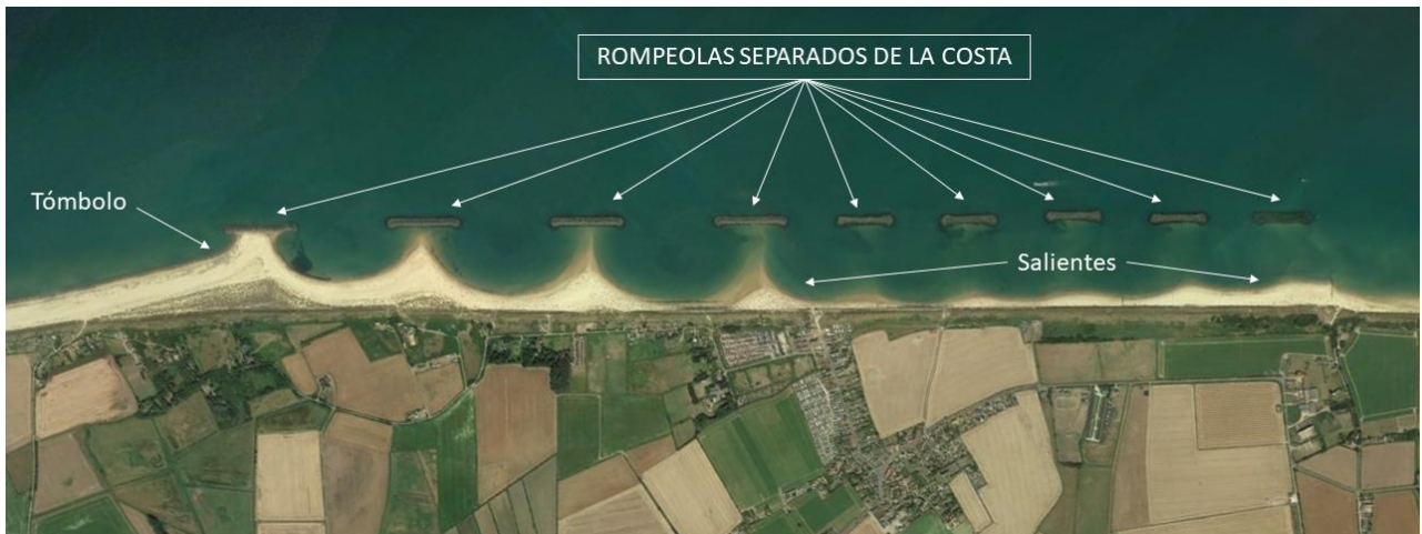
Figura 3. Batería de rompeolas separados de la costa y sus efectos en la línea de playa. Fuente: Imagen tomada de Google Earth, 2020
