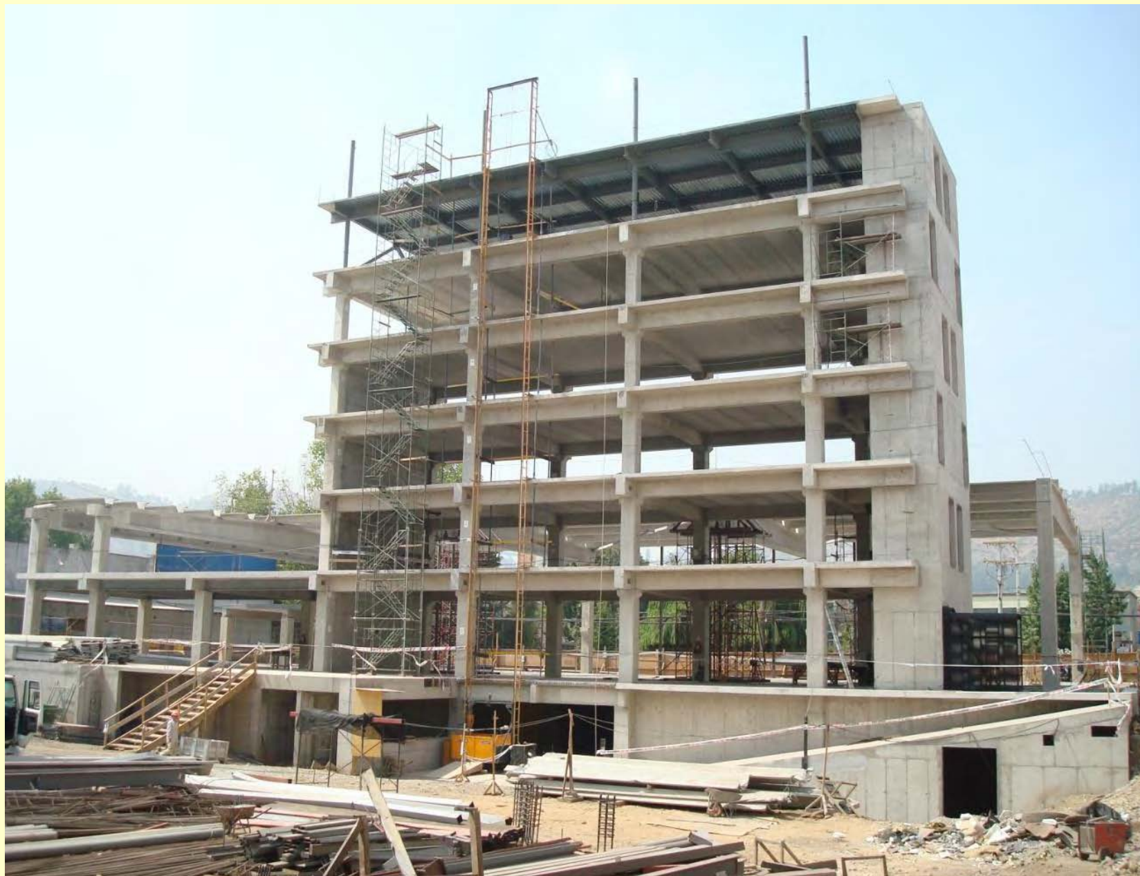
Edificio prefabricado de CR en Ciudad Empresarial
